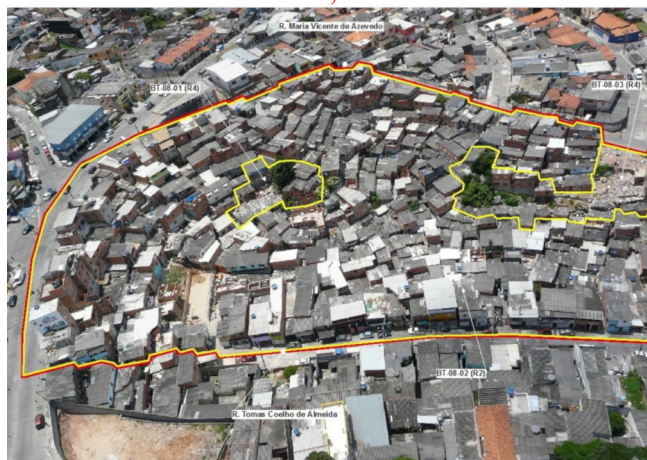
Figura 5. Exemplo de área e setores de risco identificados no mapeamento do IPT. A linha vermelha representa o limite da área, enquanto as linhas amarelas representam o limite de cada um dos setores.
